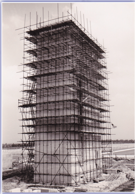
De toren in aanbouw
