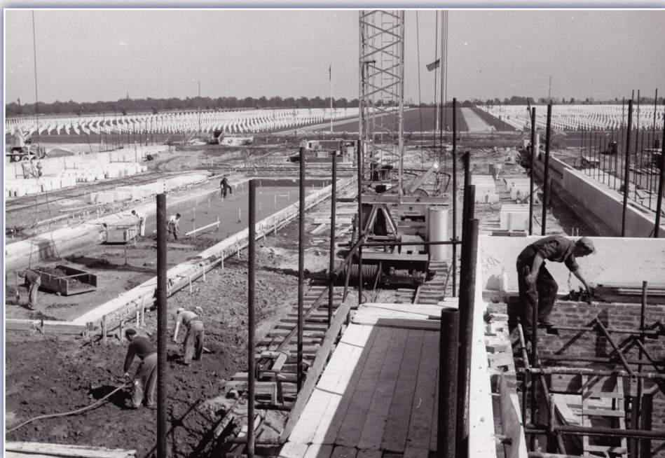
Werkzaamheden aan de Muren der Vermisten, de vijver en het kantoorgebouw
