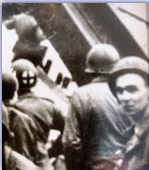
William Ray Hutchison bij de ingestorte brug in Remagen
